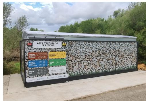
Área modular de aportación RSU sostenible, fabricada en polietileno reciclado con cubierta ventilada y luz LED solar para mobiliario urbano.
