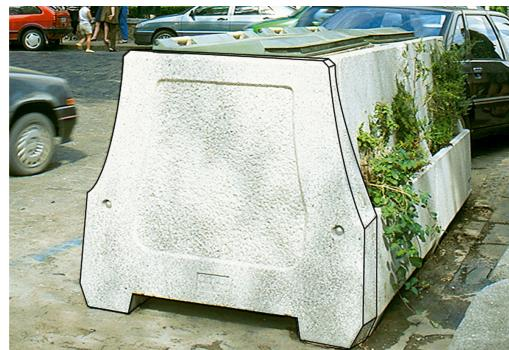
Módulo tablero de piedra artificial, para la construcción modular de islas ecológica de superficie. Se adapta al número de contenedores y a los diferentes sistemas de recogida.
