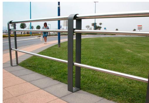
Barandilla modular de acero carbono e inoxidable 316, con postes Clip 1100 y tubos de diferentes diámetros para estructura sólida y estable. Diseño elegante y resistente para espacios urbanos.
